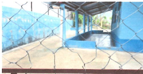
Foto 4: CERCO O MURO PERIMETRAL Sustitución malla de acero galvanizado en perímetro del establecimiento, con instalación fija y tensa, anclajes metálicos en intervalos regulares
