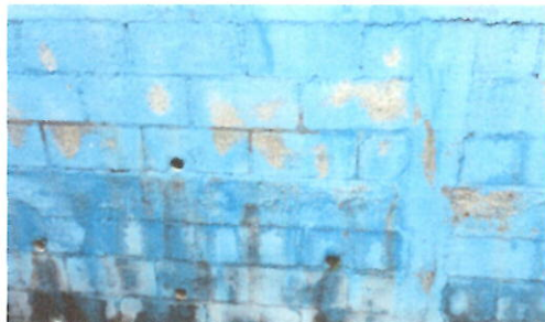
Foto 2: PINTURA EN MUROS EXTERIOR Preparación de la superficie y aplicación de pintura a dos manos, en paredes exteriores de muros
