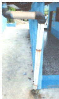
Foto 3: CANALES Y BAJADAS DE AGUA PLUVIAL sustitución de bajantes para evacuación de aguas pluviales anclada por medio de abrazaderas y tornillos
