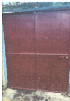
Foto1: MANTENIMIENTO A PORTONES mantenimiento a portón de ingreso, material: metálico, incluye: bisagras y sistemas de cierre.
